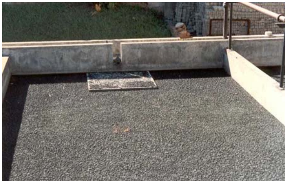
Leito com lodo na etapa final de secagem.
