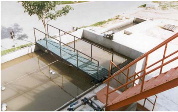
Removedores de lodo mecanizados;
