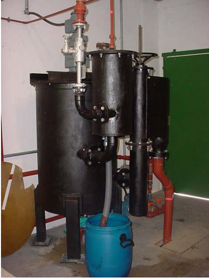
Removedores de lodo mecanizados;
